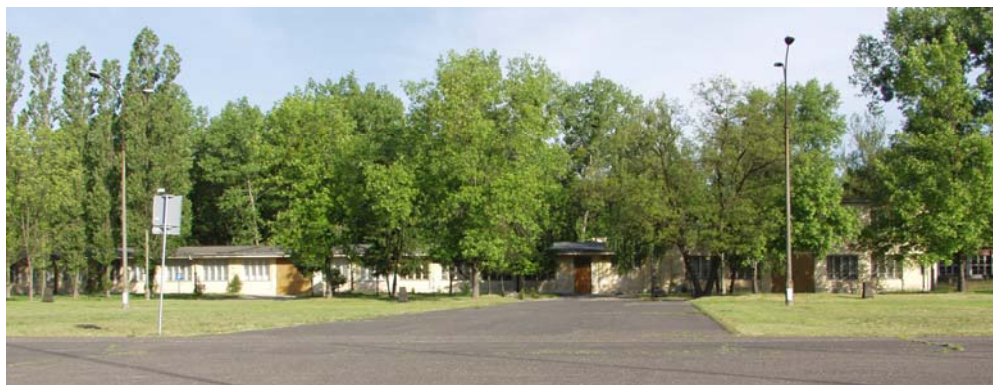
Fot.1. Budynek 69 – siedziba Zespołu Badawczego Konstrukcji Specjalnych i Balistyki
